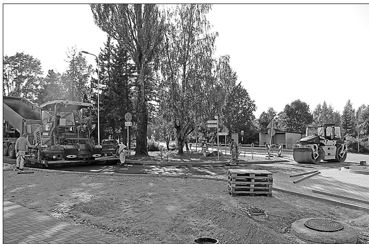
Asfalta ieklāšanas darbi Saules ielā.
